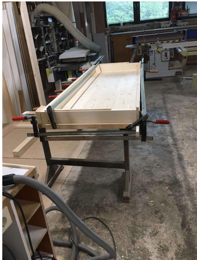
Abbildung 8 Sockel verleimen
