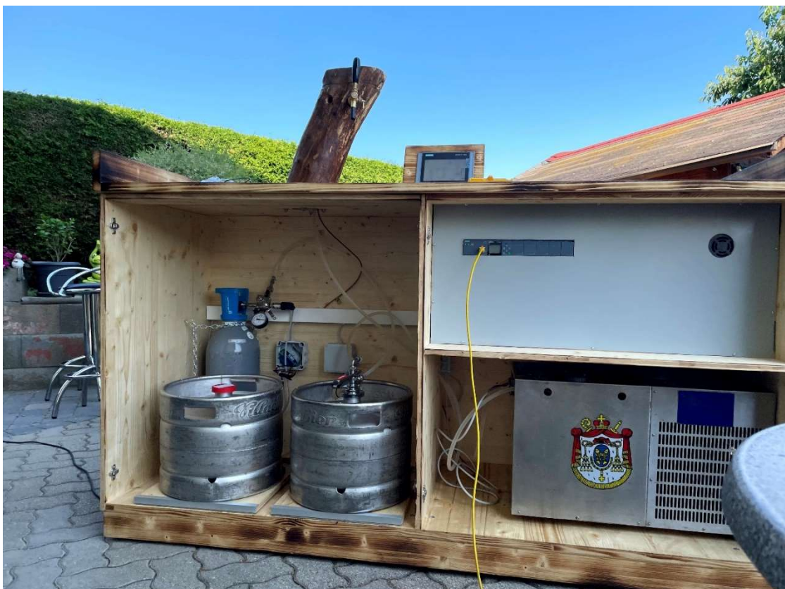
Abbildung 31 Anlage im Rohform
