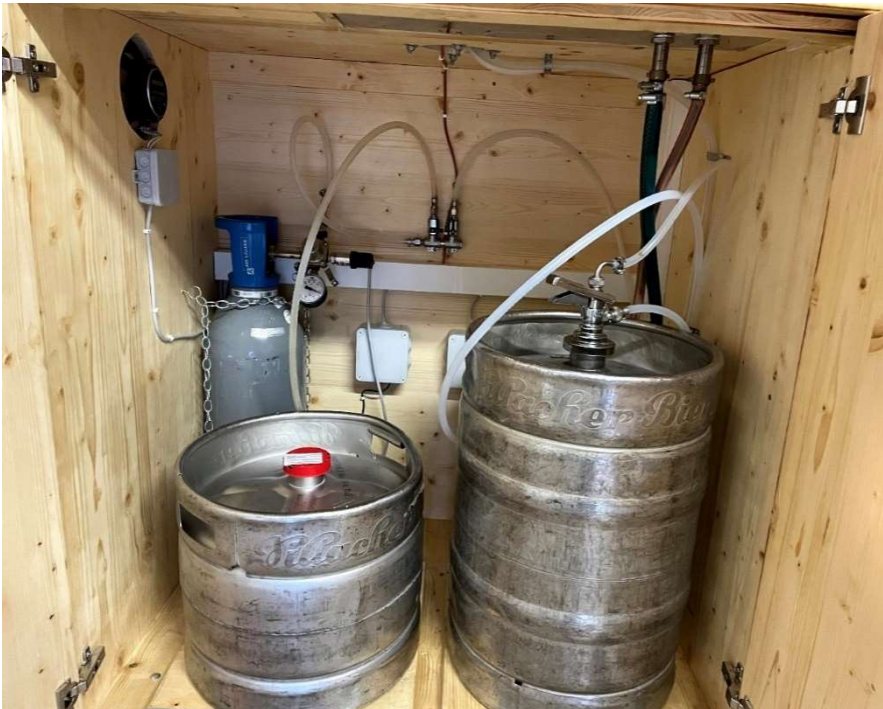
Abbildung 36 Montage Bierleitungen
