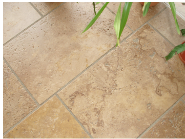
Plattenbelag Travertin teilweise Wände in Nasszellen
