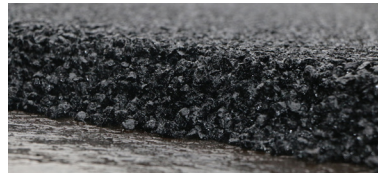
Asphalt Parkplätze und Zufahr- ten
