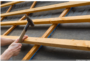
Lattungen Dach, Wände und Decken Fichte
