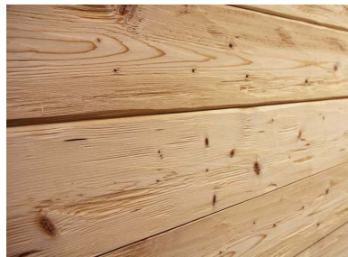
Holz Wand- und Deckenbekleidung im Innenbereich 1.5mm (Brandschutz)
