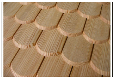
Holzschindeln Lärche Aussenfassade Bestehend und Neu
