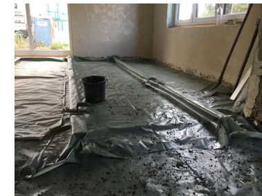
Folie für den Einbau von Styrobeton
