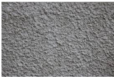
Fassade Untergeschoss neu grau gestrichen
