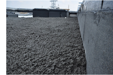
Styrobeton Verwendung als Schall- dämmung zwischen Balkenlage
