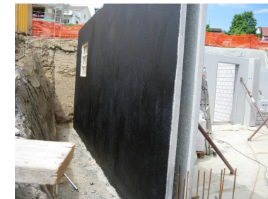
Schwarzanstrich Abdichtung unter Terrain
