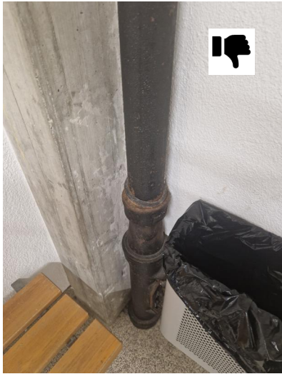
11) rostiges Gusseisenrohr
