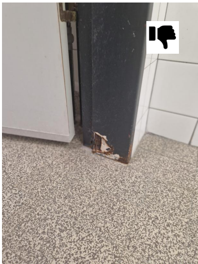
06) Beschädigte Zarge
