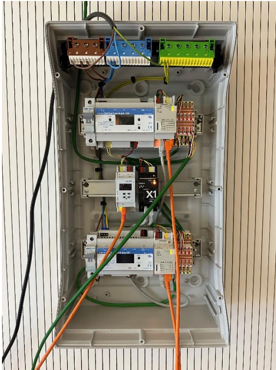
Abbildung 54: KNX-System Labor 1
