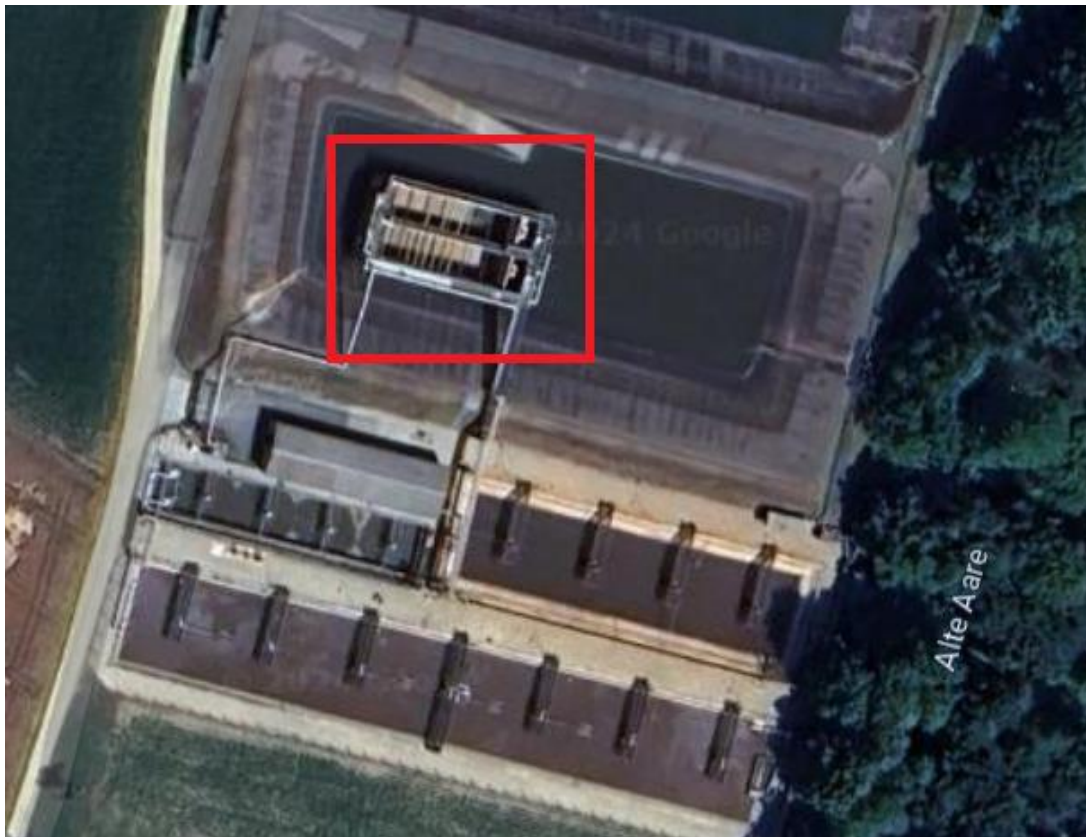
Abbildung 5 Abwasserbehandlungsanlage im Grien Aarberg
