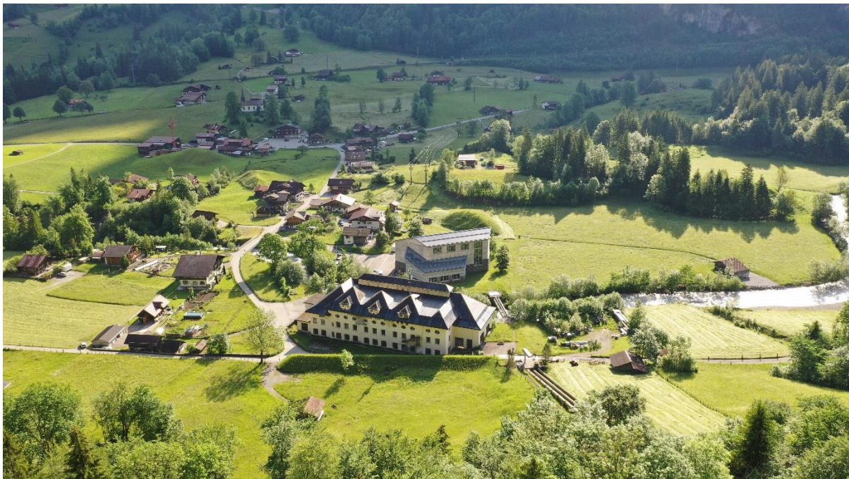
Abbildung 15 Wasserkraftwerk Kandergrund; Quelle: https://markenportal.bkw.ch/share/hyxbVi9M7DnMZVVUWXZ9
