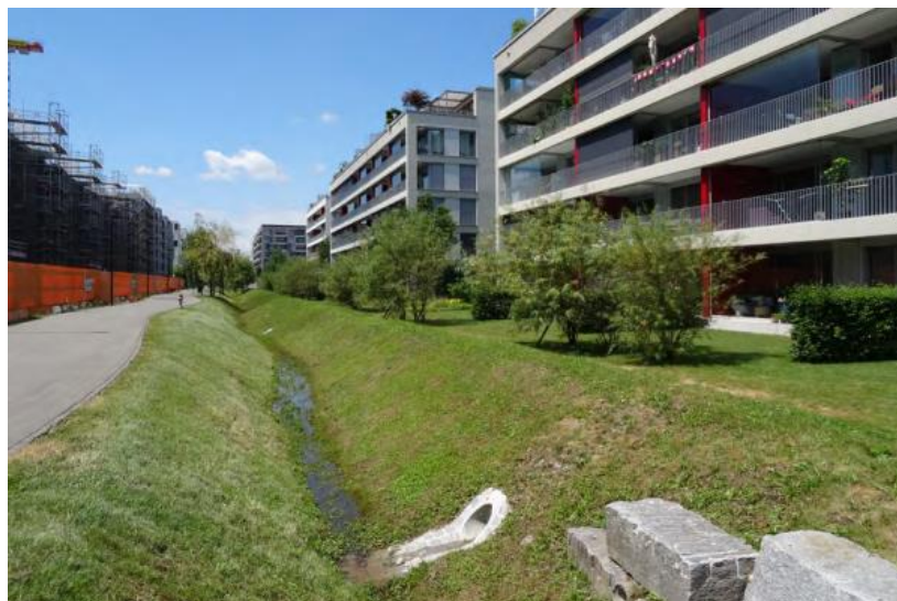
Abbildung 33: Offener Graben zur Verdunstung und Ableitung von Wasser im Opflikerpark.
