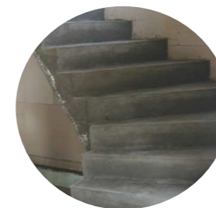
Treppenhaus Treppe in Ortbeton, natürlich belassen
