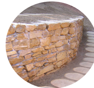
Trockensteinmauerwerk Hartgneis, Stein freiförmig
