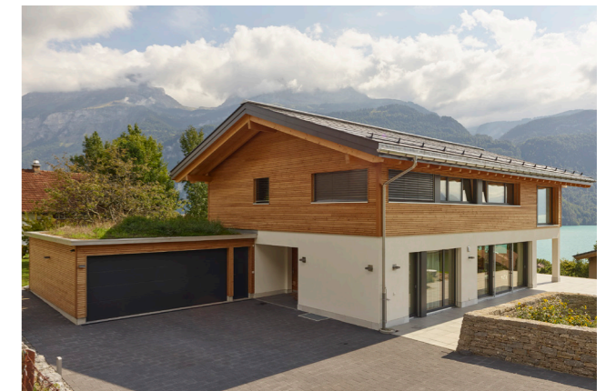
Neubau EFH, Brienz
