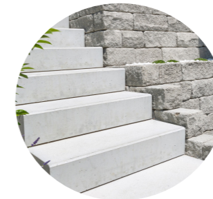
Treppenstufen zu Loggia Betonblockstufen
