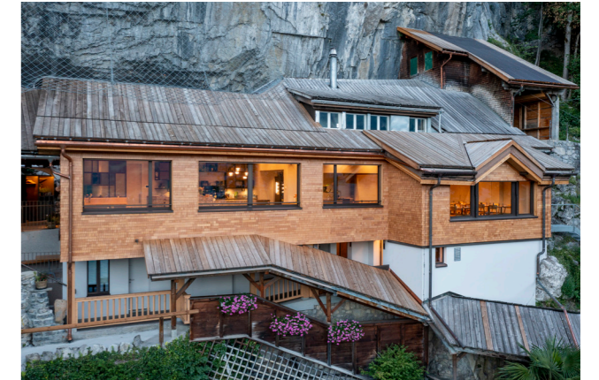
Sanierung Restaurant St. Beatus-Höhlen
