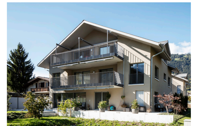
Neubau MFH, Unterseen
