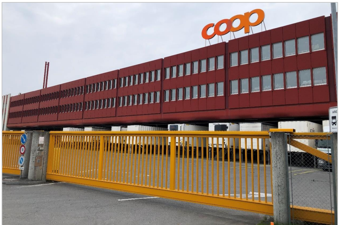
Abbildung 1: Coop Verteilzentrale in Gwatt (Quelle: eigenes Foto).
