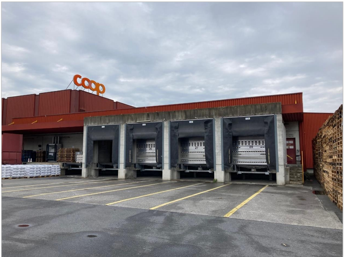
Abbildung 20: Aussenbereich des Wareneingangs (Quelle: eigenes Foto).
