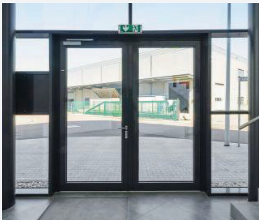
Hauseingangstür Stahl einbrennlackiert schwarz gestrichen RAL 9005
