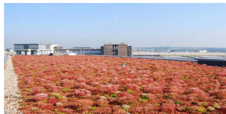
Extensive begrünung - Sedumteppich - Flachdach
