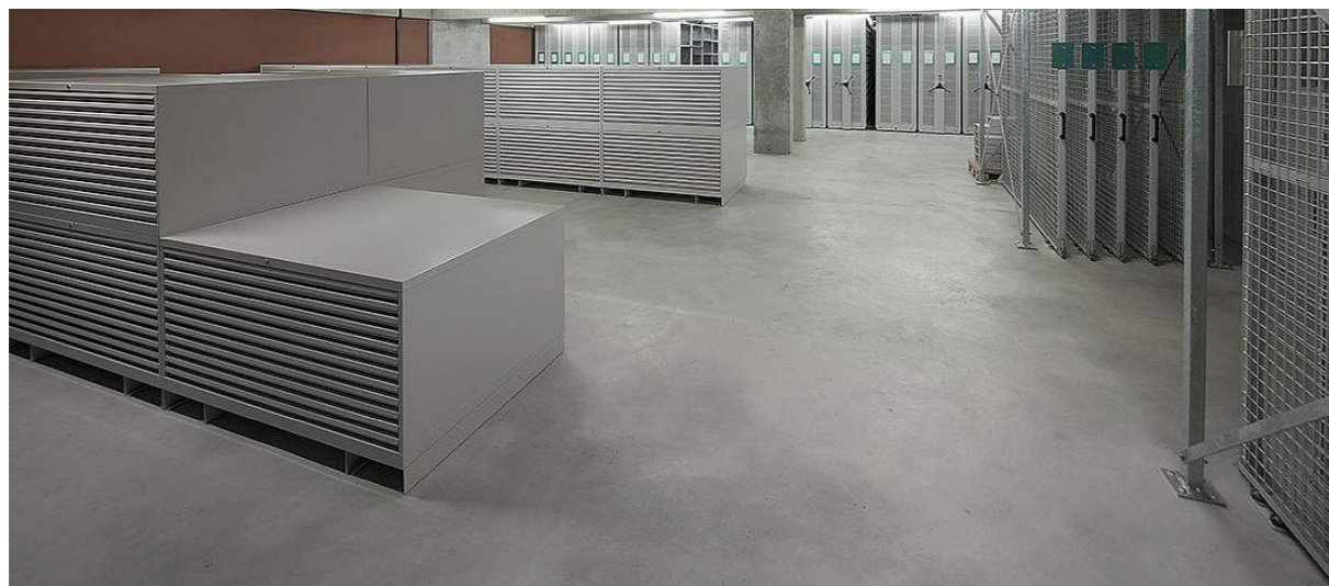
Hartbeton - Talochiert, Boden Werkstatt
