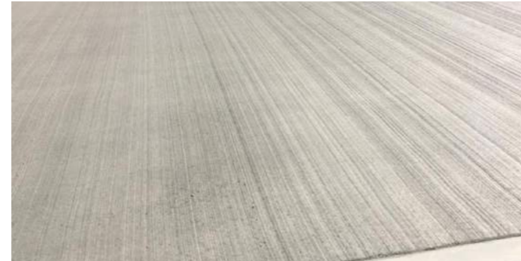
Beton - Besenstrichoberfläche - Rampe, Hartbeton Parkdeck
