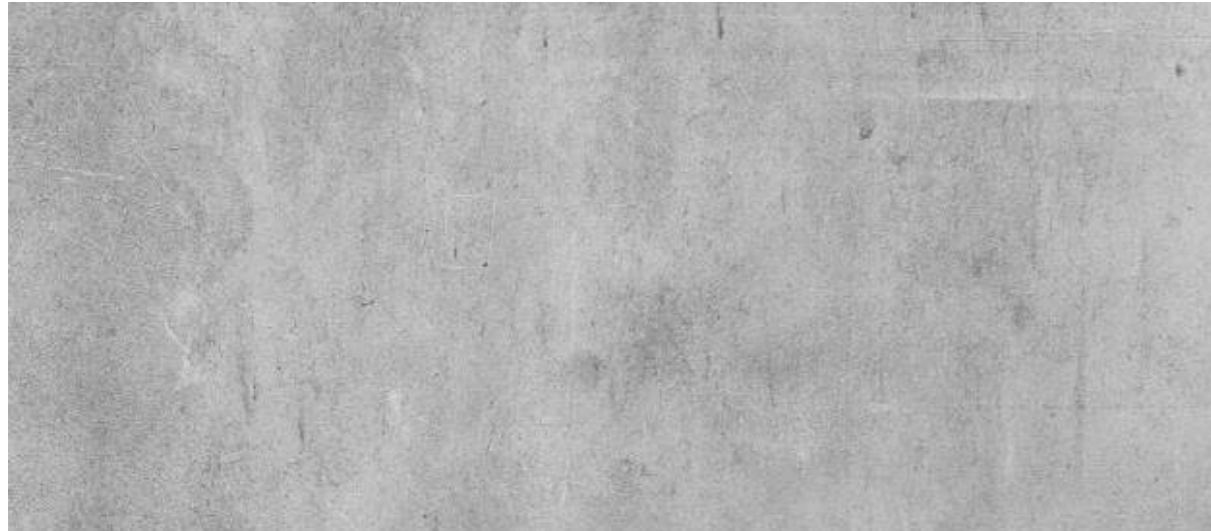
Beton - Schalungstyp 2 - Wände und Decke Werkstatt
