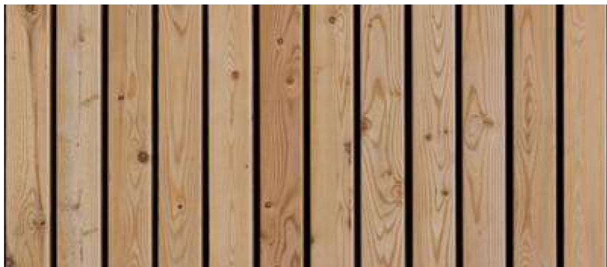
Lärchenschalung vertikal - farblos lasiert - Fassade 2.OG, Attika, Brüstung 1.OG,
