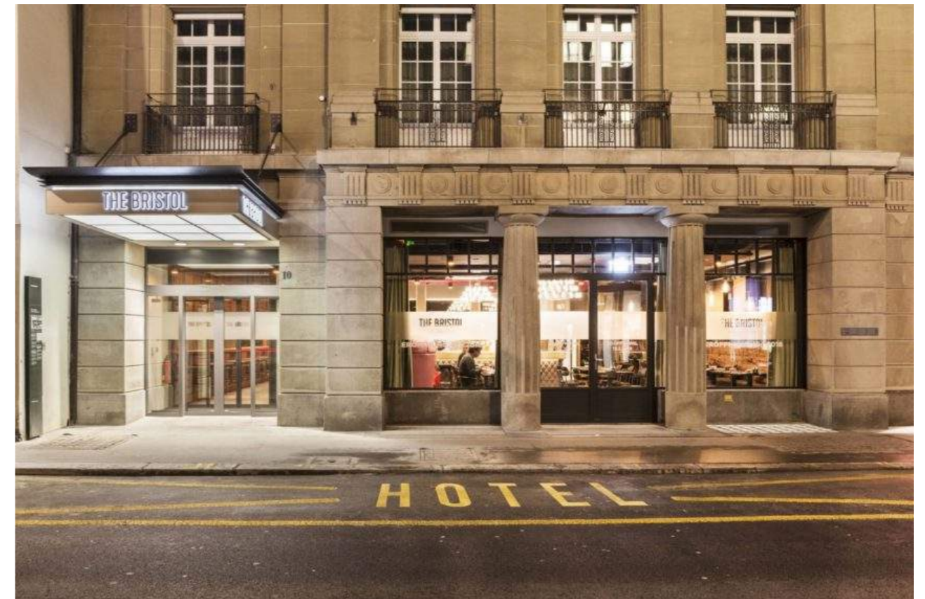
Totalsanierung, Hotel Bristol Bern, Bauleitung
