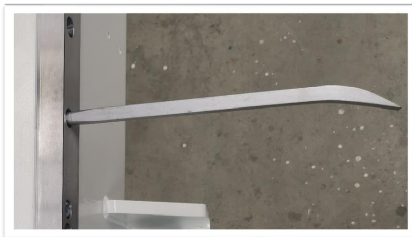
Abbildung 5: Verspannung mit dem Stemmeisen
