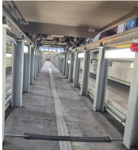
Abbildung 3-20 Verlegen von Kabelbrücken
