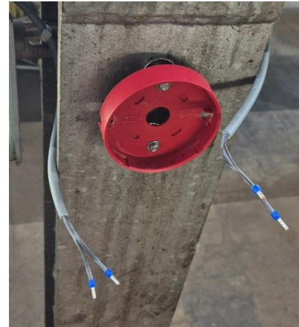
Abbildung 3-8 Leuchten-Sockelmontage
