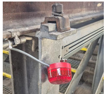
Abbildung 3-18 Temporärlösung der Leuchtmittel ist nicht alltagstauglich
