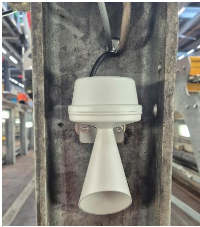
Abbildung 3-9 Montage akustisches Signalhorn
