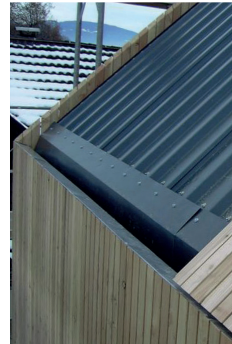
DACHRINNE EINGELASSEN VERSTECKT HINTER FASSADE
