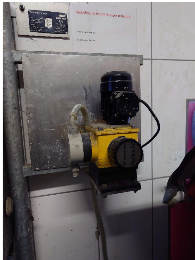
Abbildung 11: Dosiereinheit für das Flockmittel
