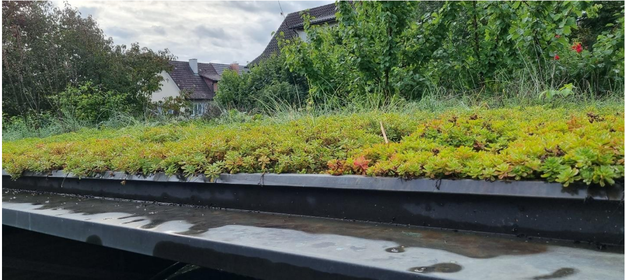
Abbildung 69 Dachbegrünung Unterstand (Eigene Aufnahme)
