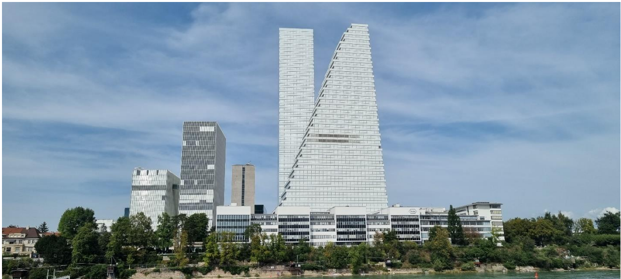
Abbildung 52 Roche-Tower (Eigene Aufnahme)
